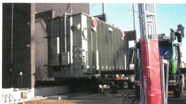
Den ene transformator er ved at komme på plads. Ikke så ligetil. Den vejer 202 ton. Når den er komplet og fyldt med olie, kommer den op på 310 ton.
