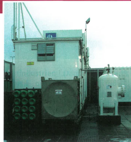
Disse billeder er fra en brinttankstation i Reykjavik på Island. Her produceres strømmen ved hjælp af geotermisk energi, ensrettes og bruges til elektrolyse af vand. Oxygen-molekylerne sendes ud i luften, mens brinten sendes over i de blå tanke. Herfra kan folk via standeren på billedet herover komme og tanke brint.
