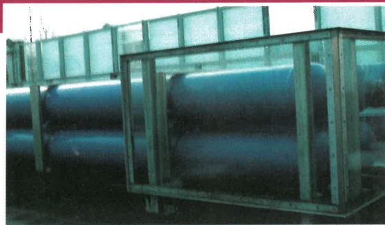
Disse billeder er fra en brinttankstation i Reykjavik på Island. Her produceres strømmen ved hjælp af geotermisk energi, ensrettes og bruges til elektrolyse af vand. Oxygen-molekylerne sendes ud i luften, mens brinten sendes over i de blå tanke. Herfra kan folk via standeren på billedet herover komme og tanke brint.
