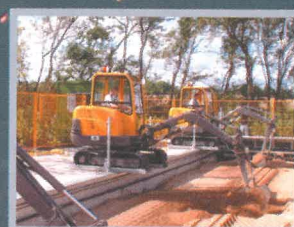
Lær om hydraulik i en rigtig gravemaskine
