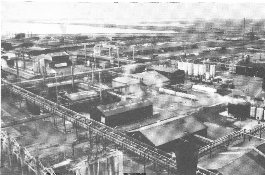
Fabriksanlægget på Rønland består af en lang række enkeltanlæg individuelt forbundet via rørbroer.
