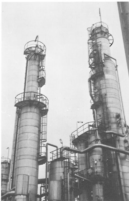
Fig. A. Til højre destillationskolonnen, hvori råolien deles op i fem fraktioner ved 360^{\circ}\text{C} . Til venstre en destillationskolonne, hvori den lavestkogende fraktion adskilles yderligere i gas og benzin.
